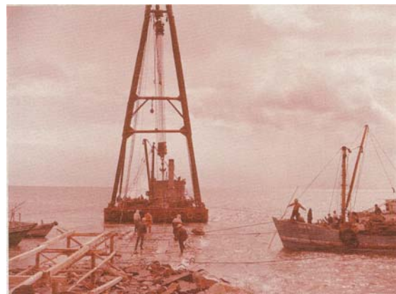
【工業港の基礎工事の様子】
