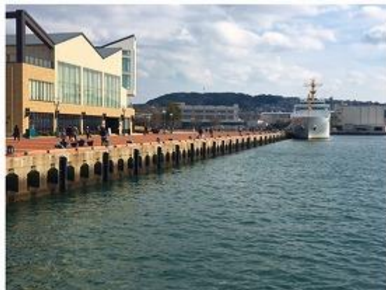
Fender 10m interval 20.
