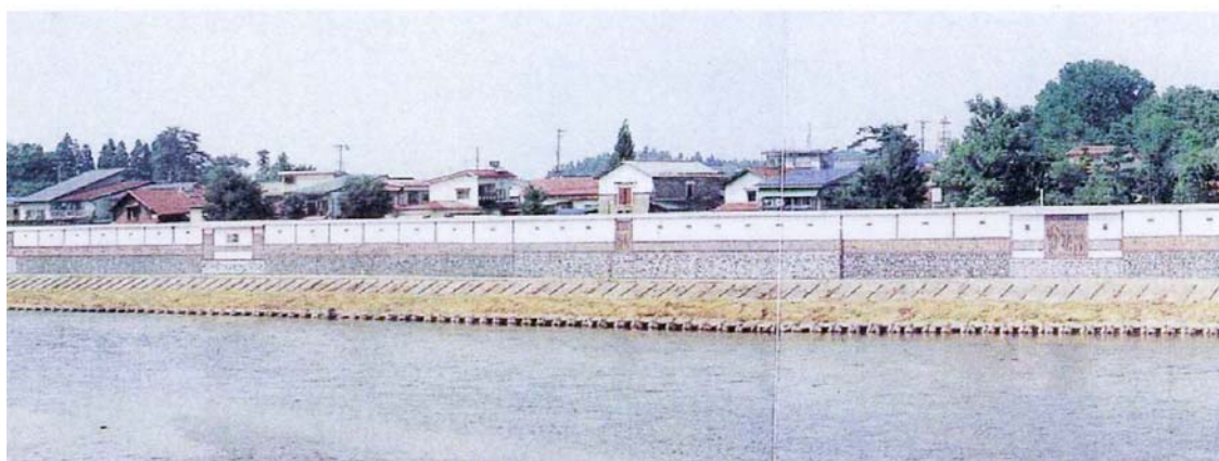
【大石田河岸場にできた護岸特殊堤防】 (写真提供 国土交通省新庄河川事務所)
