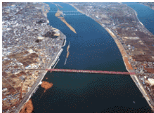
【現況写真】(三重県県土整備部 港湾・海岸室)
