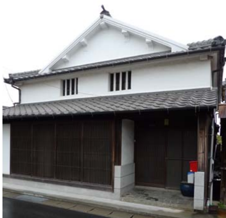
【図-5 船大工を営んだ柳井屋の町家建築遺構】
