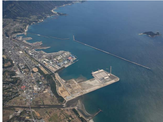
【現況写真】(鹿児島県港湾空港課)
