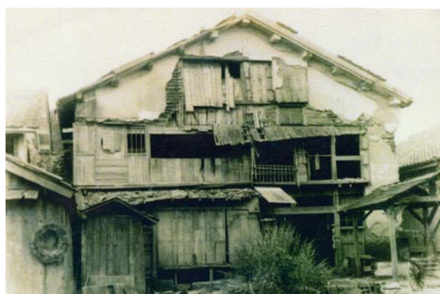
【中山宗五郎屋敷裏（側昭和35年取壊された東棟）】 (昭和35年撮影)
